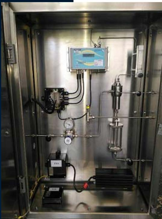
Manalytical 公司的 Optima Auto-Zero 系统能够在污染比较严重的应用场合以及维修很困难的场所中提供精确的水分在线分析。
